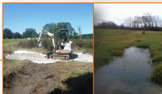
Frayère de Thurey-le-Mont, pendant et après travaux
