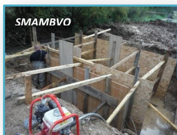
Etape de construction d'un passage supérieur (Frayère de la Morte Jacquot, Cromary/Perrouse)
